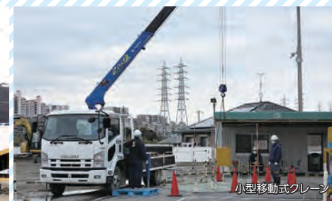
小型移動式クレーン
