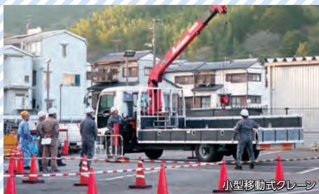
小型移動式クレーン
