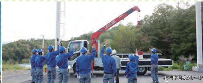
小型移動式クレーン
