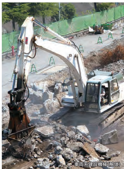
車両系建設機械(解体)
